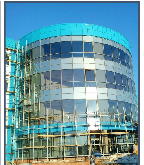
Stan 5000 / Vıksa/ RF Fabrika Ofis Binası 2012
