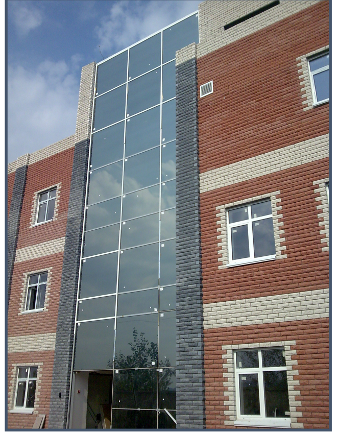
Şişecam Paşabahçe Tesisleri / Bor / RF Fabrika Ofis Binası 2008
